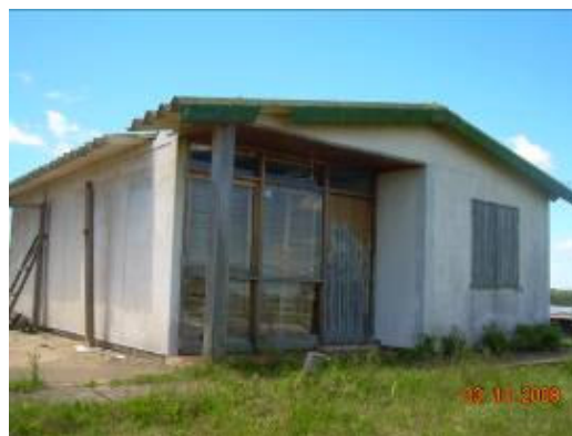
VIVIENDA EXISTENTE (PREFABRICADA)
